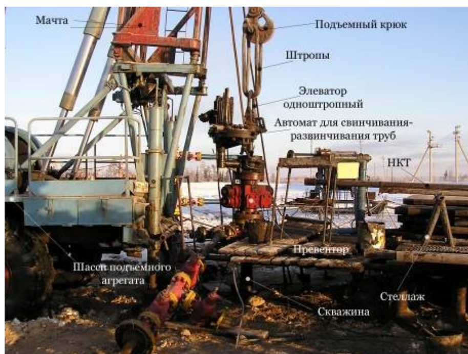
Рис. 14.2. Подъемный агрегат на устье ремонтируемой скважины
