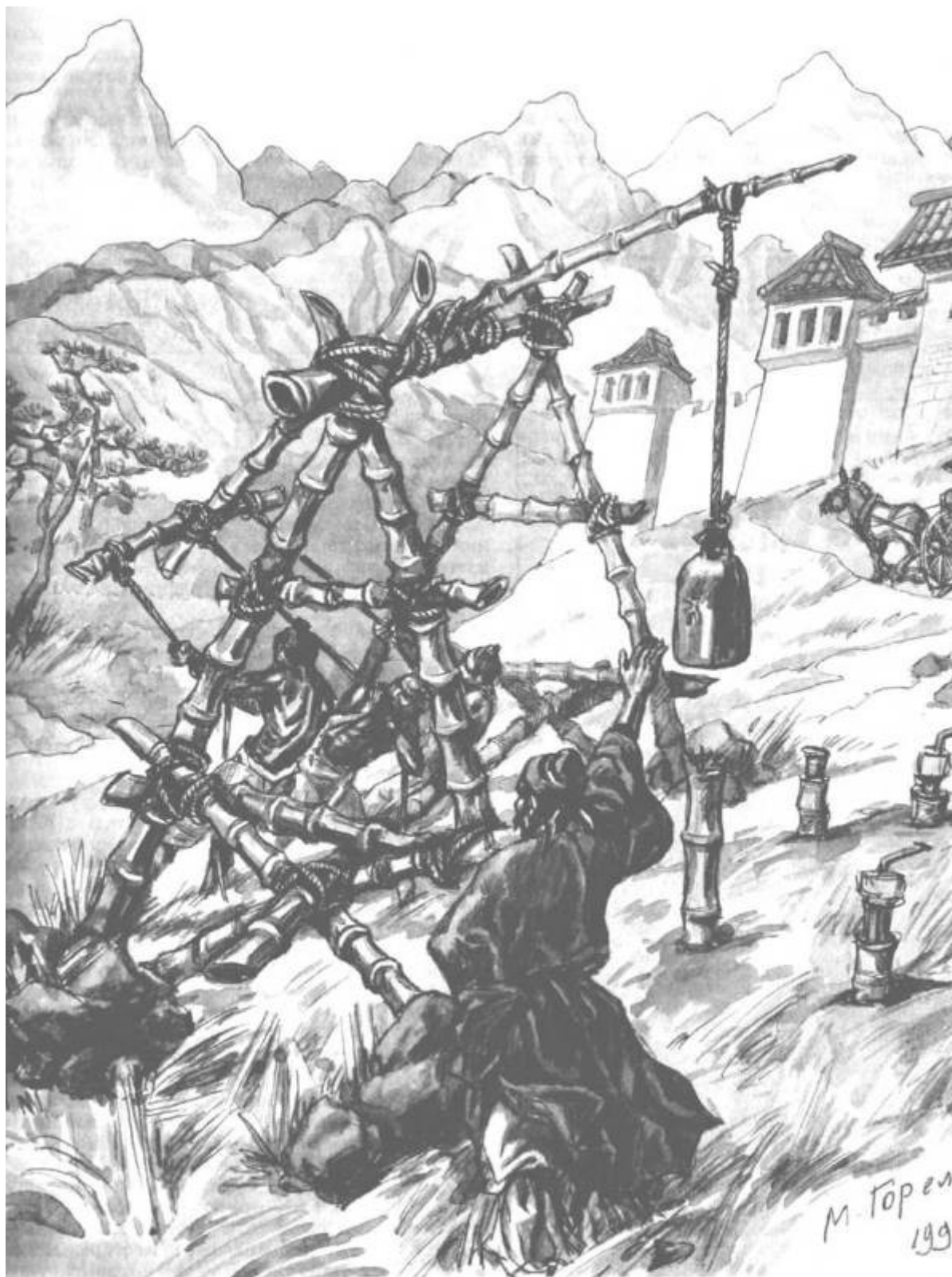
Рис 1.2. Сооружение скважин в Китае: бронзовой колотушкой в скважину забивается обсадная труба из бамбука
