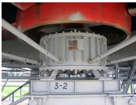
Рис. 1.19. Установка электродвигателя осевого вентилятора в АВО [39]
